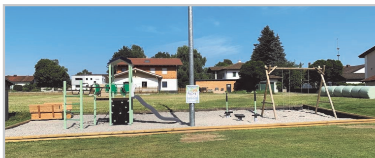
Neubau eines Spielplatzes in Binabiburg
