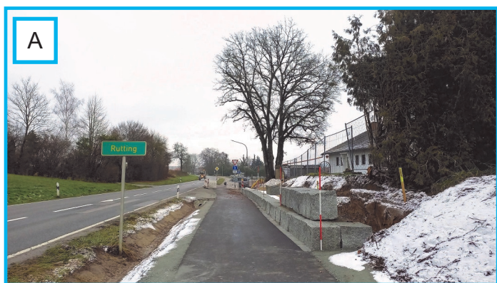
stützende Steinmauer bei Rutting
